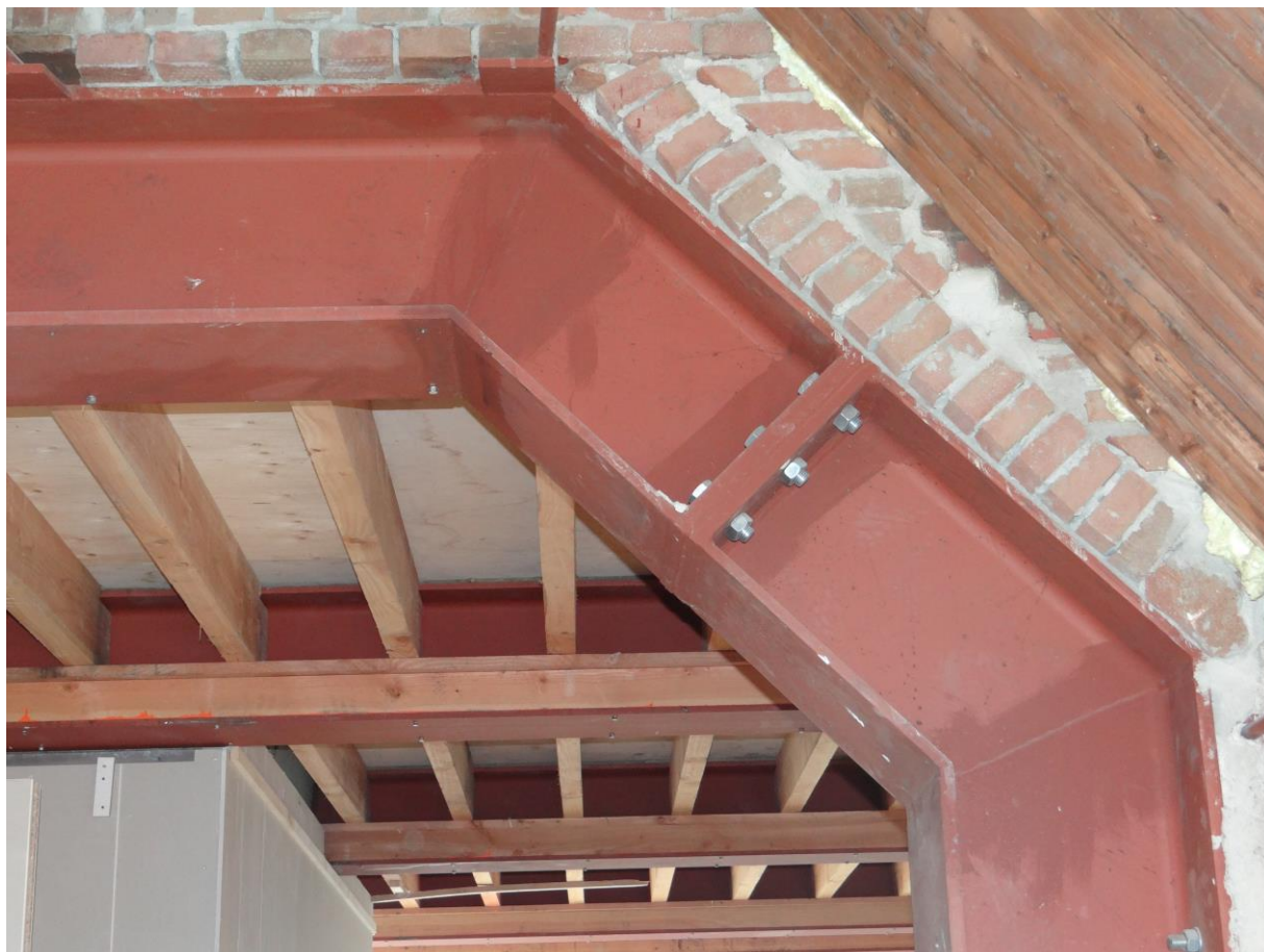
Detailfoto verbouwing Delft
