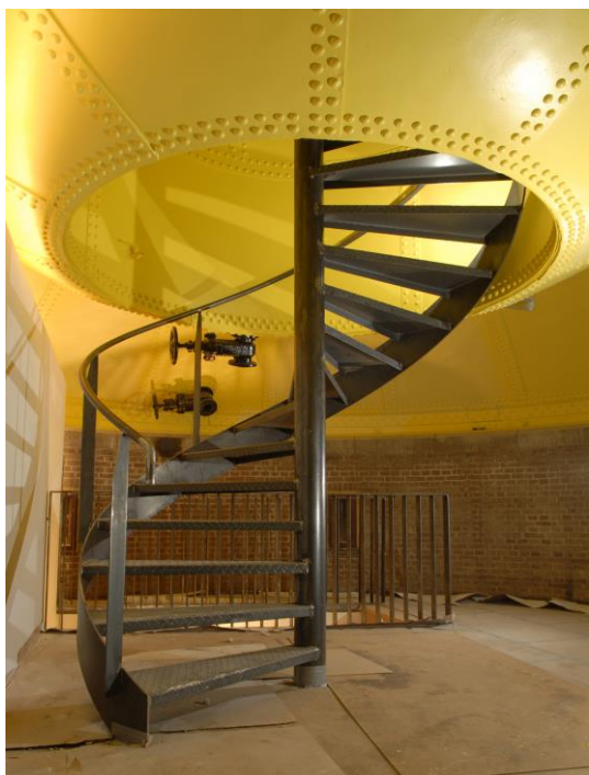
Spiltrap Watertoren te Delft
